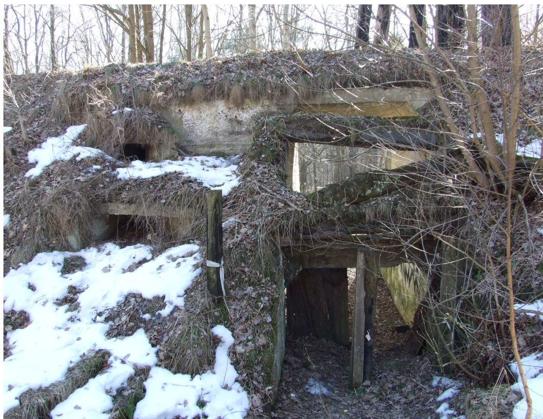
Strzelnica przy Lotnisku Babice, okienka obserwacyjne i wejście do schronu, 2013 r. Fot. Artur Jaroń
