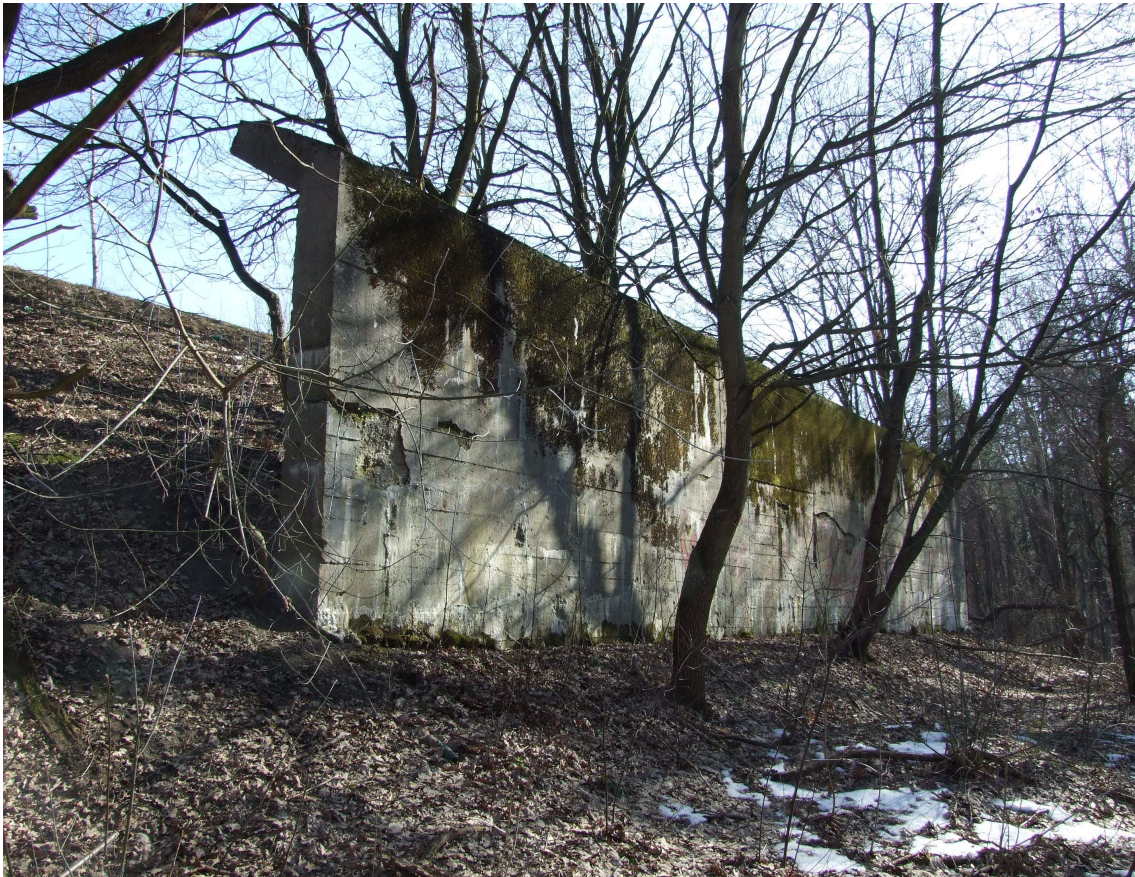
Strzelnica przy Lotnisku Babice, betonowa ściana oporowa za kulochwytem głównym, 2013 r. Fot. Artur Jaroń
